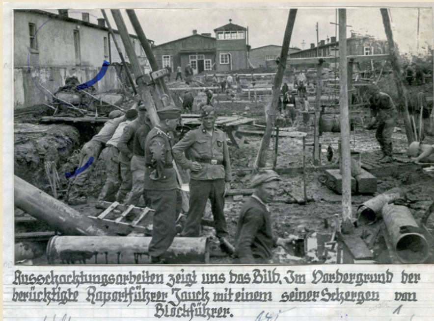
Ewald Jauch bei Ausschachtungs- und Fundamentierungsarbeiten beim Ausbau des KZ Neuengamme, um 1942
